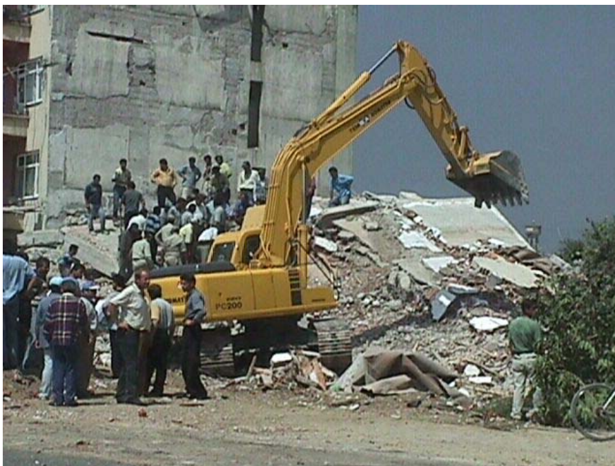
شکل ۴: آوار برداری با استفاده از بیل مکانیکی در زلزله ۱۹۹۹ ایزمیت
