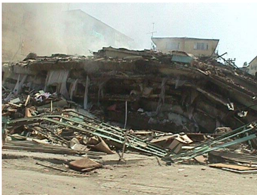
شکل ۲: آوار بصورت "پن کیک" - زلزله ۱۹۹۹/ایزمیت
