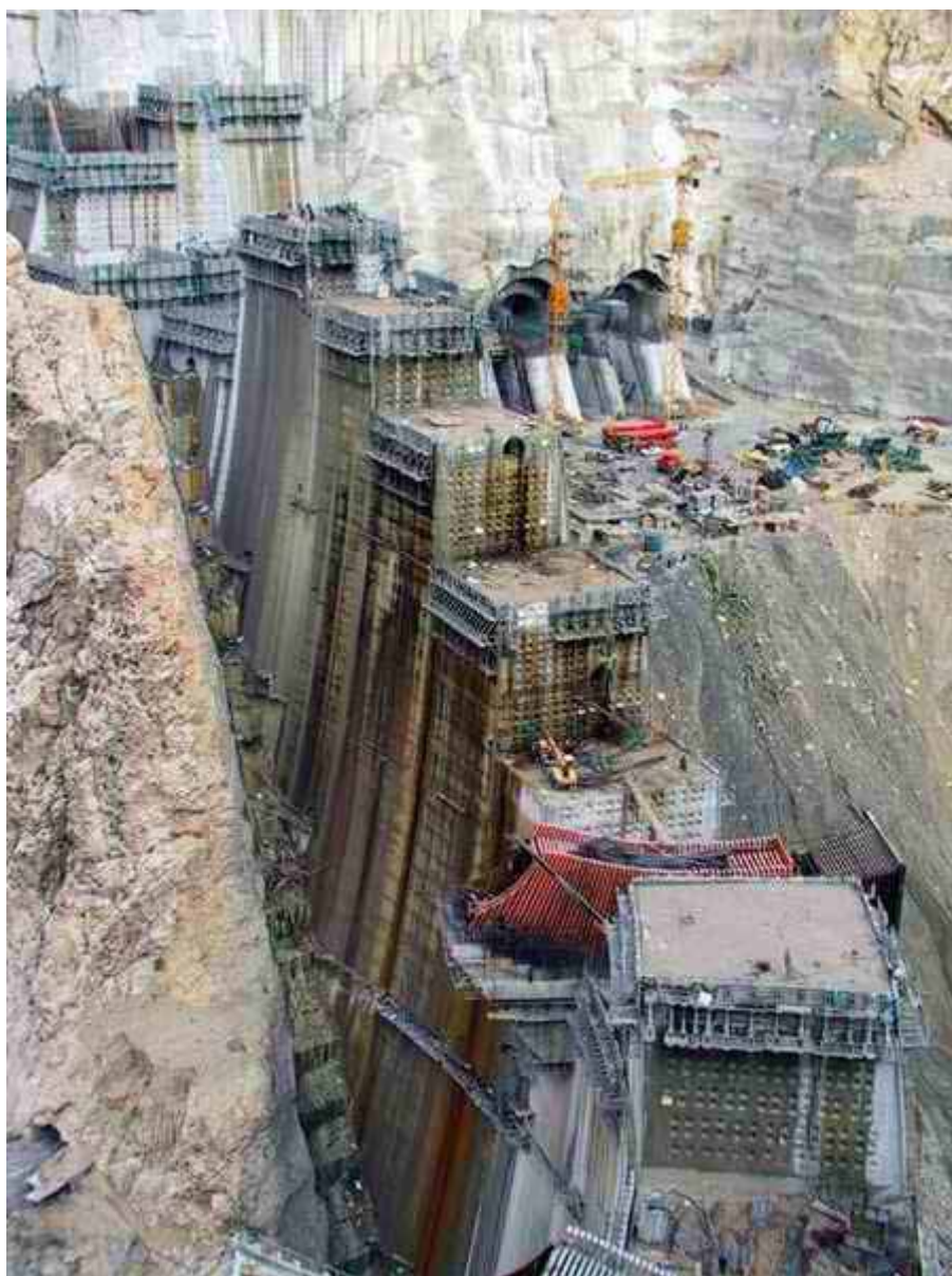
نمایی از سد کارون ۳ در حال ساخت
