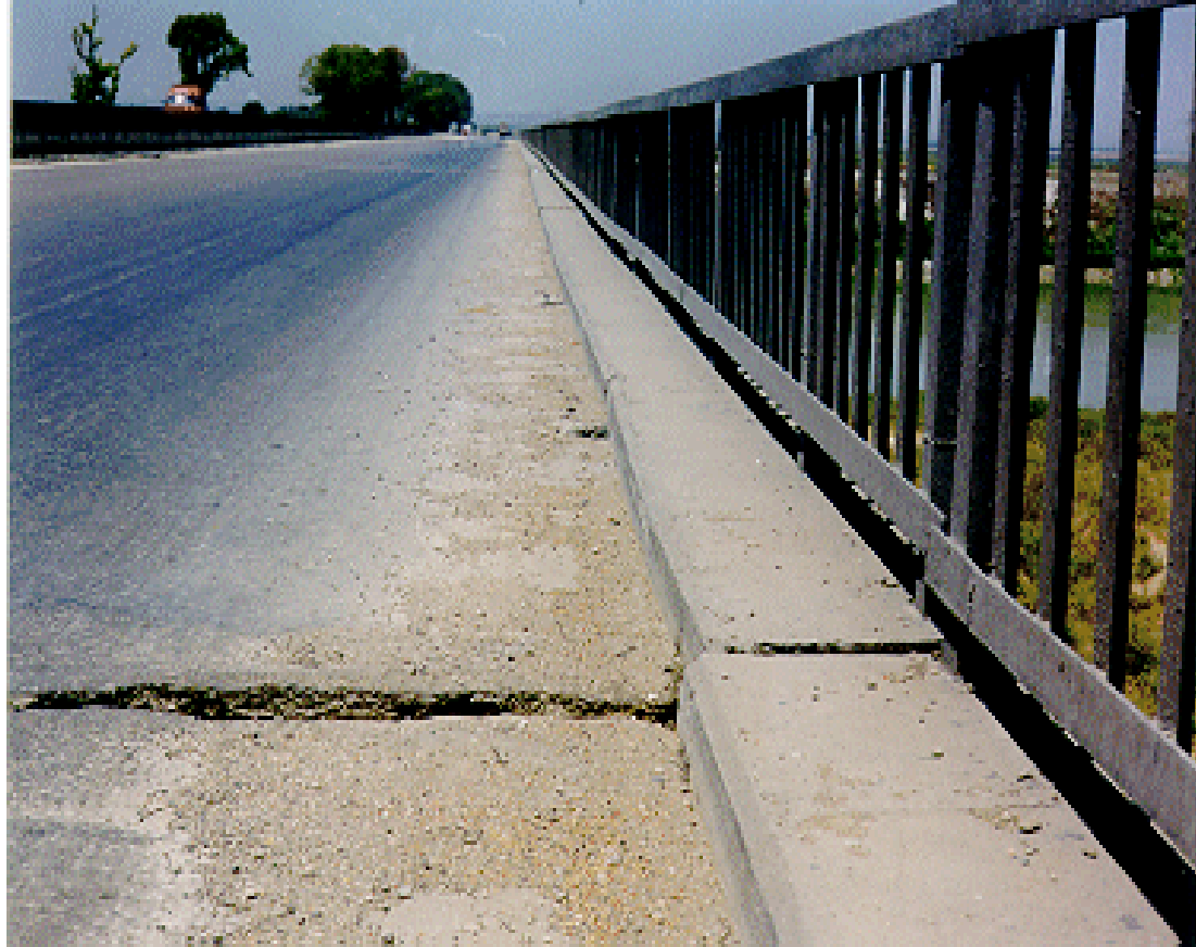
Resim-4 Adana-Gaziantep Yolundaki Ceyhan Köprüsü Ayaklarını Bağlayan Kirişlerde Hasar
