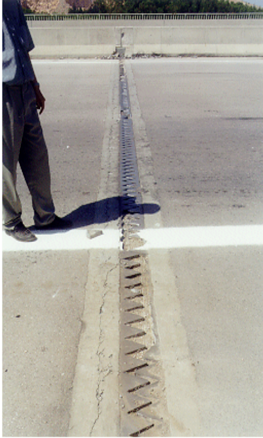
Resim-11 Ceyhan Viyadüğünde Kırılmış Tabliye Arası Derz Dişleri Picture-11 Broken Teeth At The Joints Of The Bridge Deck On The Ceyhan Viaduct
