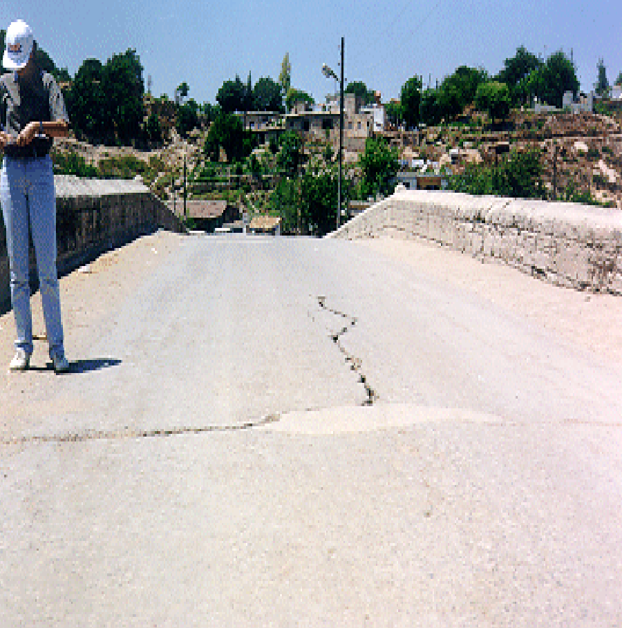
Resim-13 Misis Köprüsü Üzerinde Çatlak Picture-13 Cracks On The Misis Bridge
