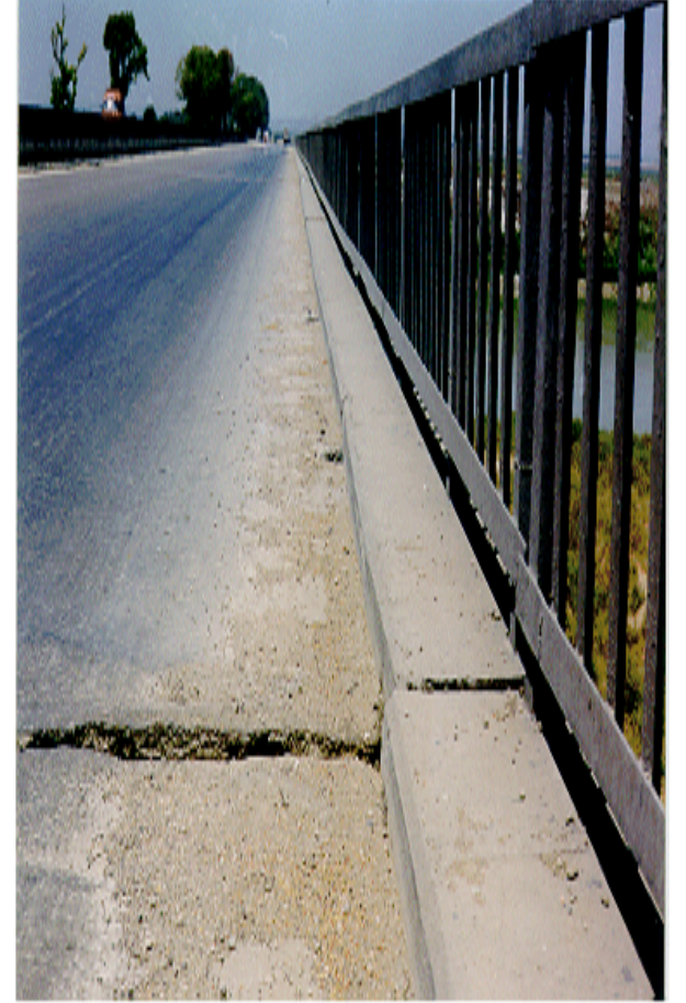
Resim-4 Adana-Gaziantep Yolundaki Ceyhan Köprüsü Ayaklarını Bağlayan Kirişlerde Hasar Picture-4 Damage On The Beams Connecting The Piers Of The Ceyhan Bridge On The Adana-Gaziantep Highway
