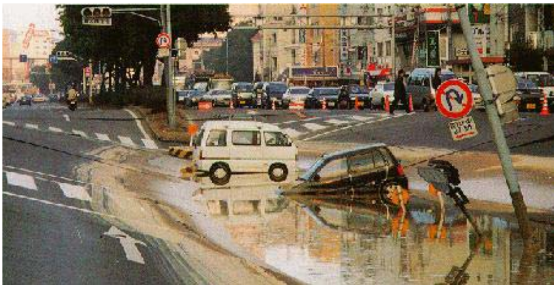
شکل ۵ وضعیت نشست سطح زمین بعد از زلزله در اثر خرابی ستونهای میانی
