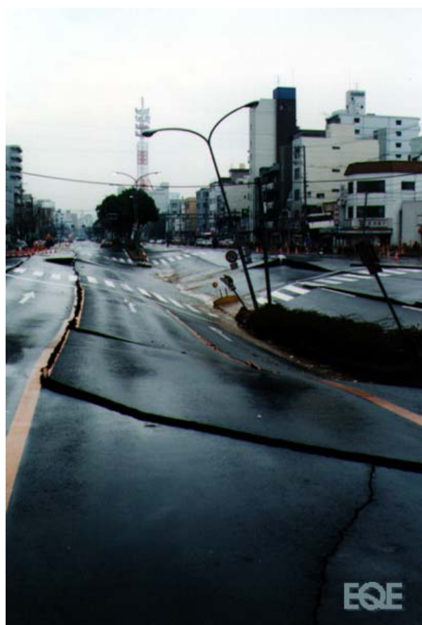
شکل ۶ وضعیت نشست سطح زمین بعد از زلزله در اثر خرابی ستونهای میانی
